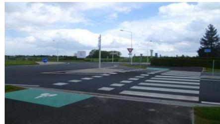
*Exemple de projet adapté* Un projet d'aménagement du carrefour RD 938 / RD 228 dans le cadre de l'aménagement de boucles cyclables.
