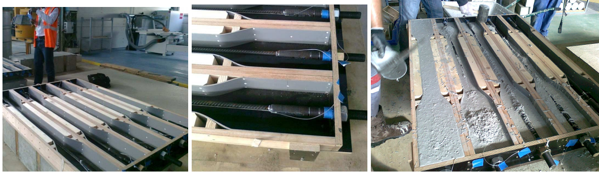
Figure 9 : Préparation des corps d'épreuve testés en traction directe, vue rapprochée de l'élargissement des têtes autour des barres de gros diamètre transmettant l'effort, détail de la mise en place du BFUP
