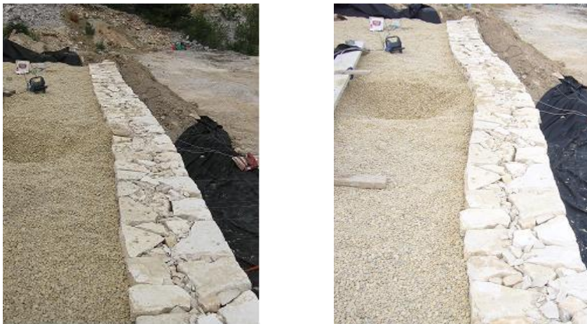
Figure 3.4. Déformation du mur après le chargement
