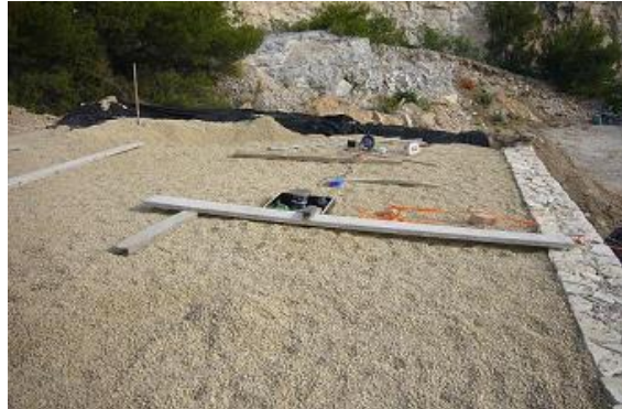
Figure 3.2. Remblai à l'arrière du mur
