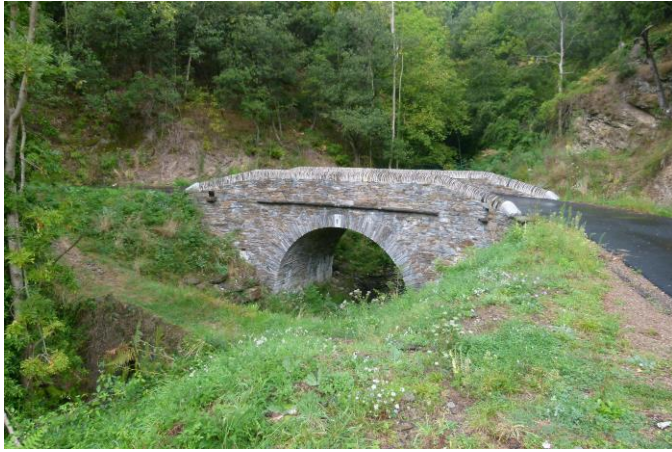
Figure 3.6 : Pont de Chaldecoste - fin de travaux, © Paul Mc Combie
