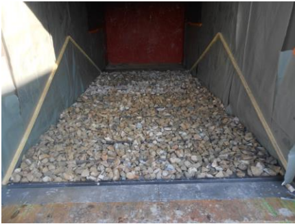
Figure 3.10 : Base de l'enrochement
