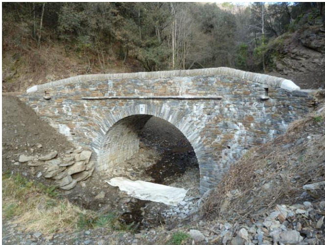
Figure 2.4 : Pont de Chaldecoste - fin de travaux
