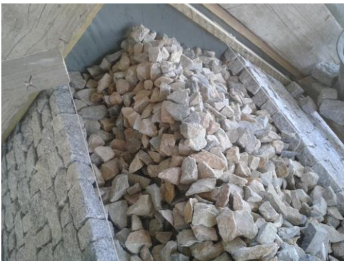
Figure 3.11 : Perré en construction
