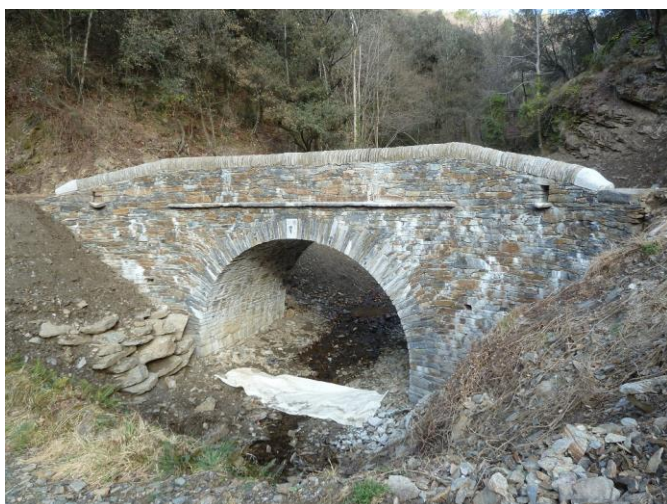
Figure 5.11 : Pont de Chaldecoste- fin de travaux
