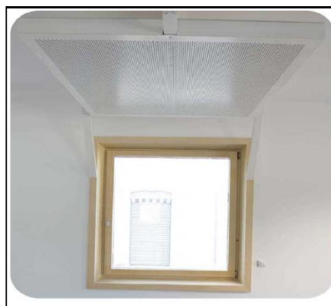
Exemple traitement de pont thermique
