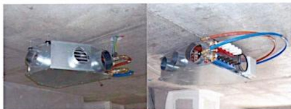
Module de chauffage ALDES
