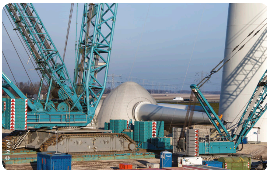
Chantier d'une éolienne terrestre
