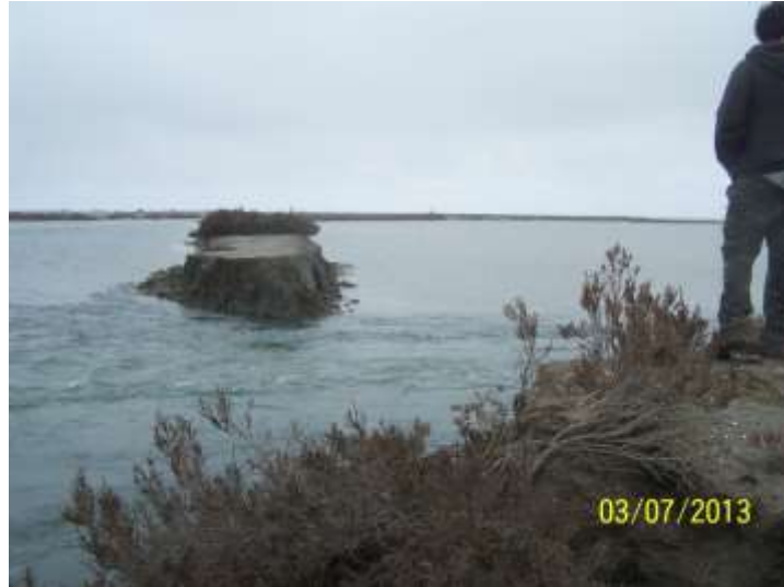
Figure 17 : photographie de la brèche d'environ 10 m de large survenue entre Vaisseau 1 et Vaisseau 2 (l'eau s'écoule de Vaisseau 1 vers Vaisseau 2).
