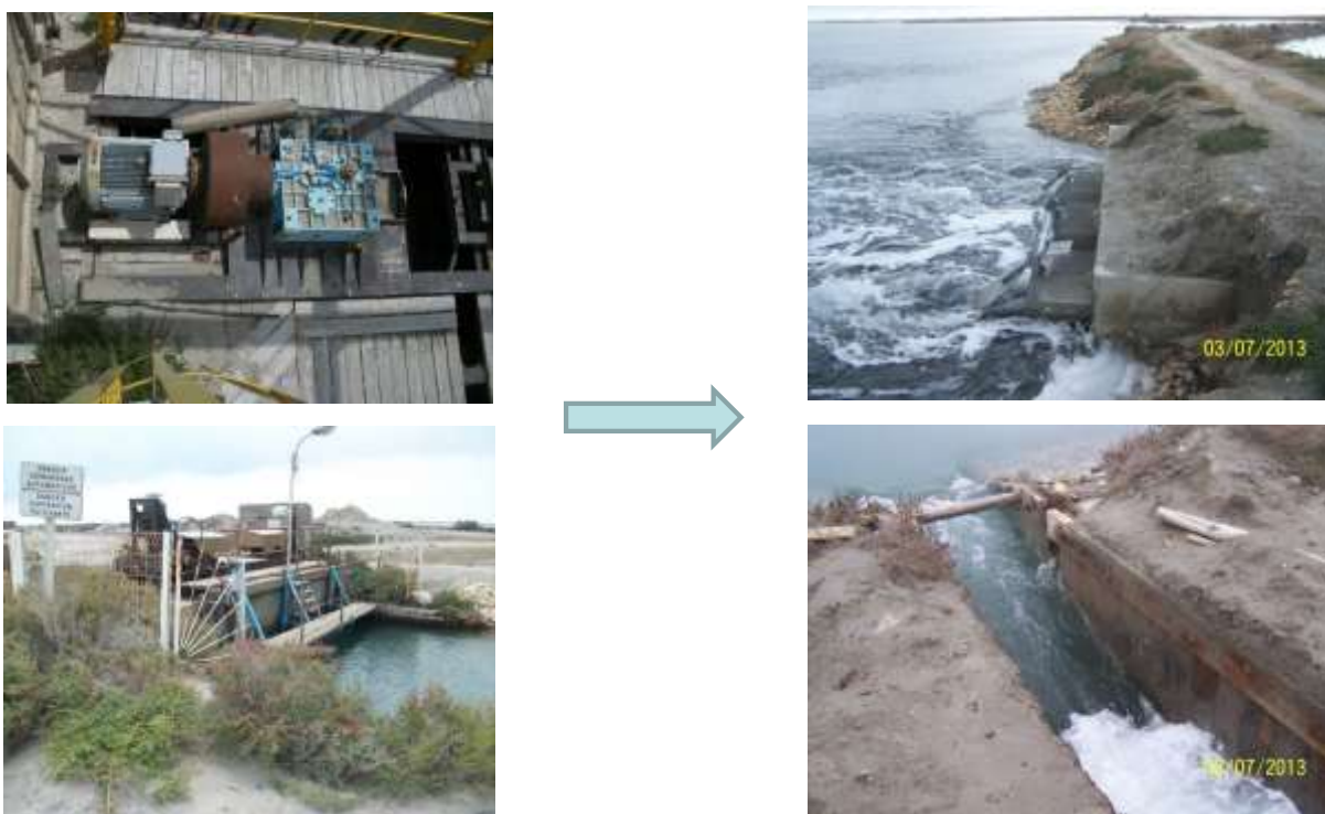
Figure 6 : Un des grands objectifs de gestion fixé : passer d'un site avec une hydraulique gérée par un système de pompes à un site où les mouvements d'eau seront induits par le vent, les échanges d'eau avec les hydrosystèmes alentours, et la gestion des ouvrages hydrauliques.
