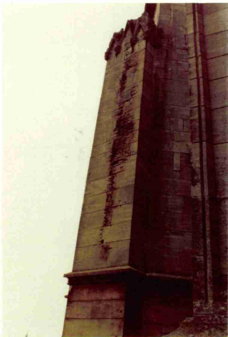
Pilier ouest vu du site échantillonné, avec alvéolisation par ruissellement
