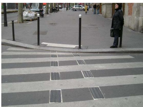
**Photo 11 :** Des bandes guides d'aveugles permettent de guider leur trajet lorsque les bandes d'éveil de vigilance sont posées de biais
