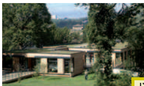
→ FIGURE 9 Toiture végétalisée : Centre aéré de Caluire (Atelier Richard Plottier Architectes)
