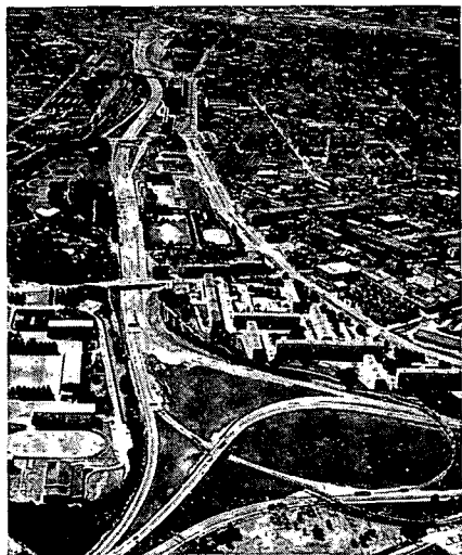
Sud de Lille (Vue d'ensemble du boulevard périphérique)
