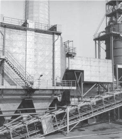
Usine d'incinération de résidus urbains d'Ivry-sur-Seine, chaîne d'extraction du mâchefer (à droite, on aperçoit le silo à cendres volantes)
