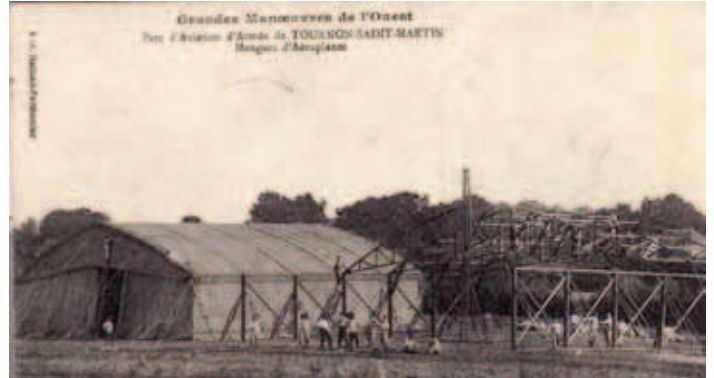
Hangars Bessonneau, 1912. ©Vital Ferry
