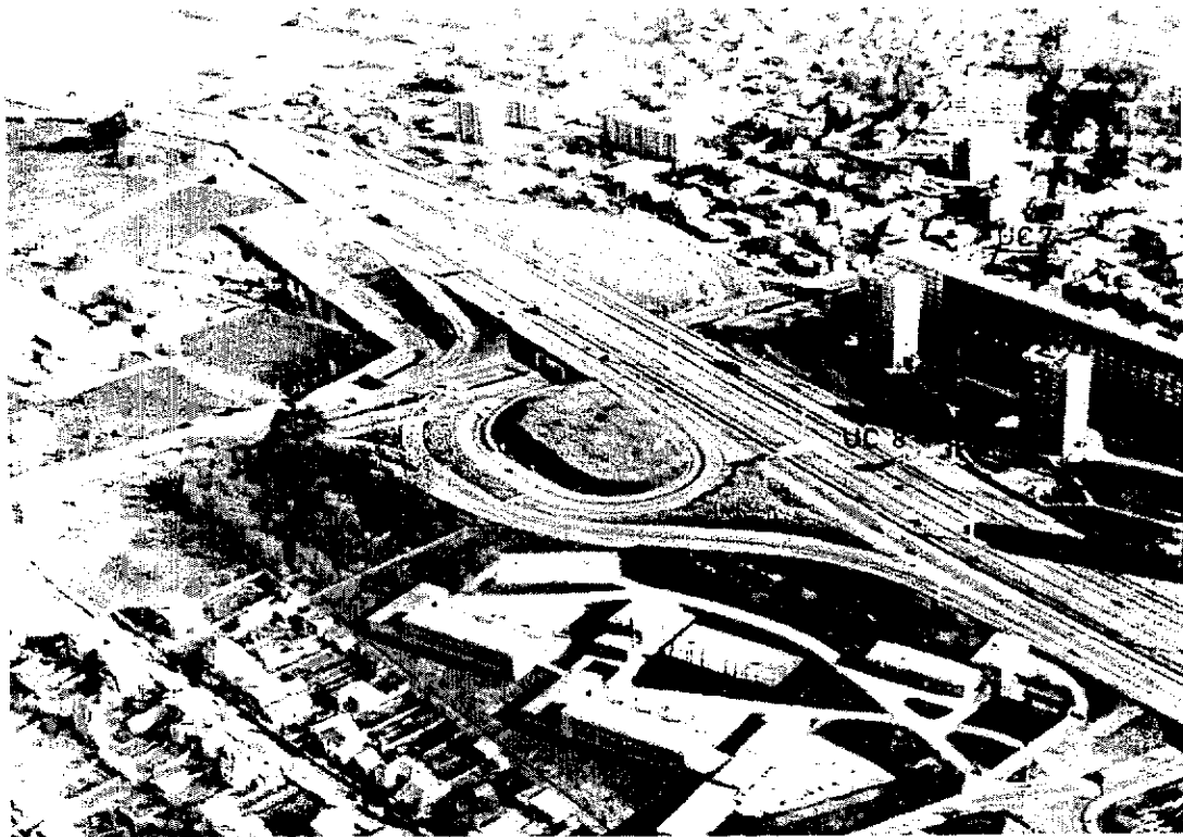
Figure 6 : Bron Prailly, Boulevard Périphérique (RN 383), ouvrage de franchissement de la RD 506
