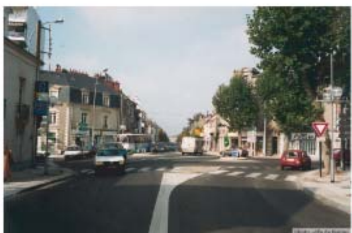
Rond-point de Rennes après aménagement
