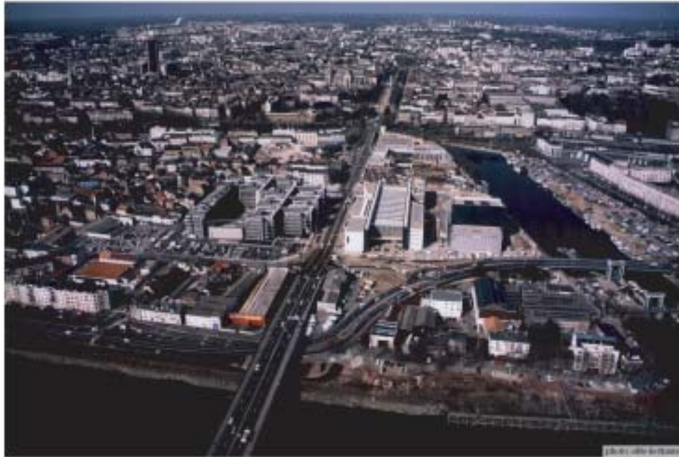
En cours de travaux
