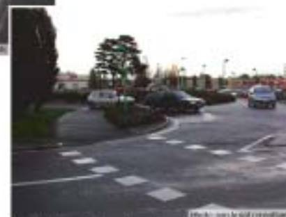
Trottoir cyclable autour du rond-point
