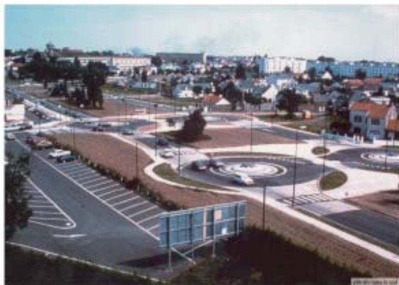
Les aménagements ont permis de créer un espace de ralentissement
