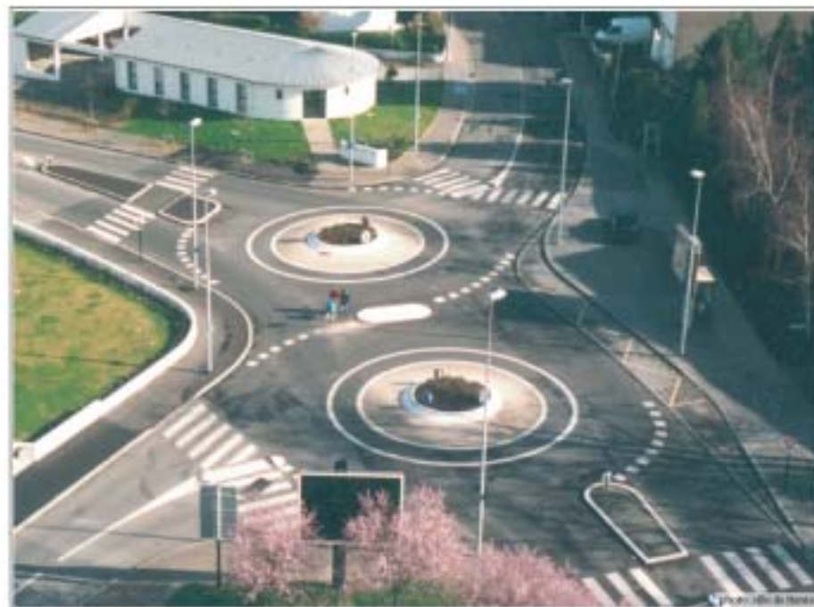
Carrefour de Port Boyer : après aménagement
