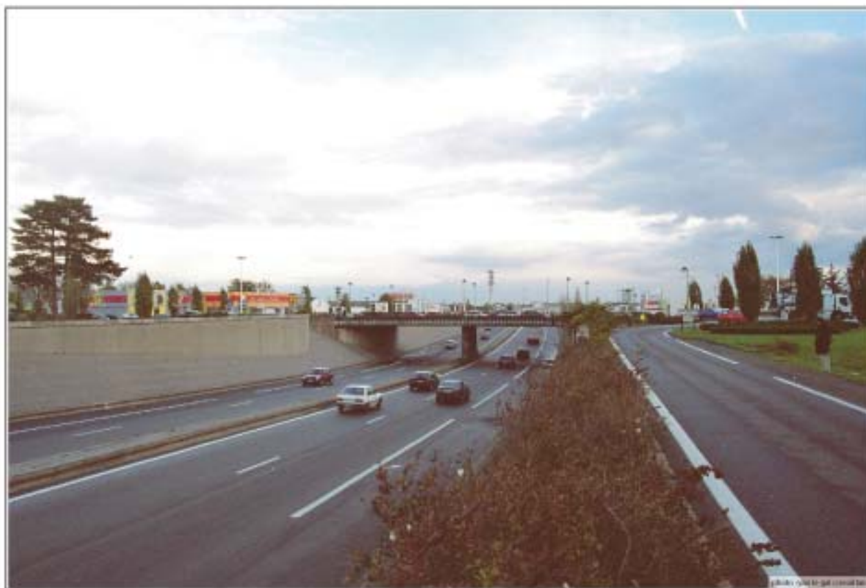
La réalisation des bretelles de l'échangeur a cherché à minimiser l'espace consommé
