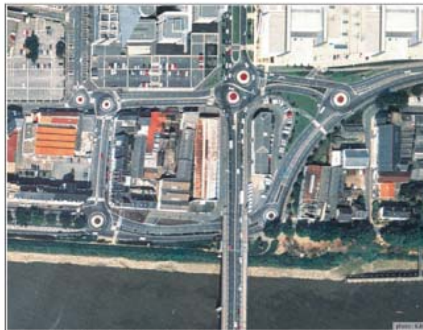
Les carrefours de l'échangeur après aménagement
