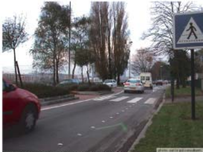
Petits clous pour les cyclistes au niveau des passages piétons
