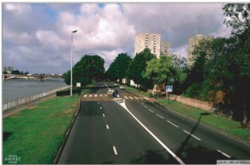
Boulevard de Sarrebrück avant aménagement : 2 x 1 voie, une voie "trop rapide"
