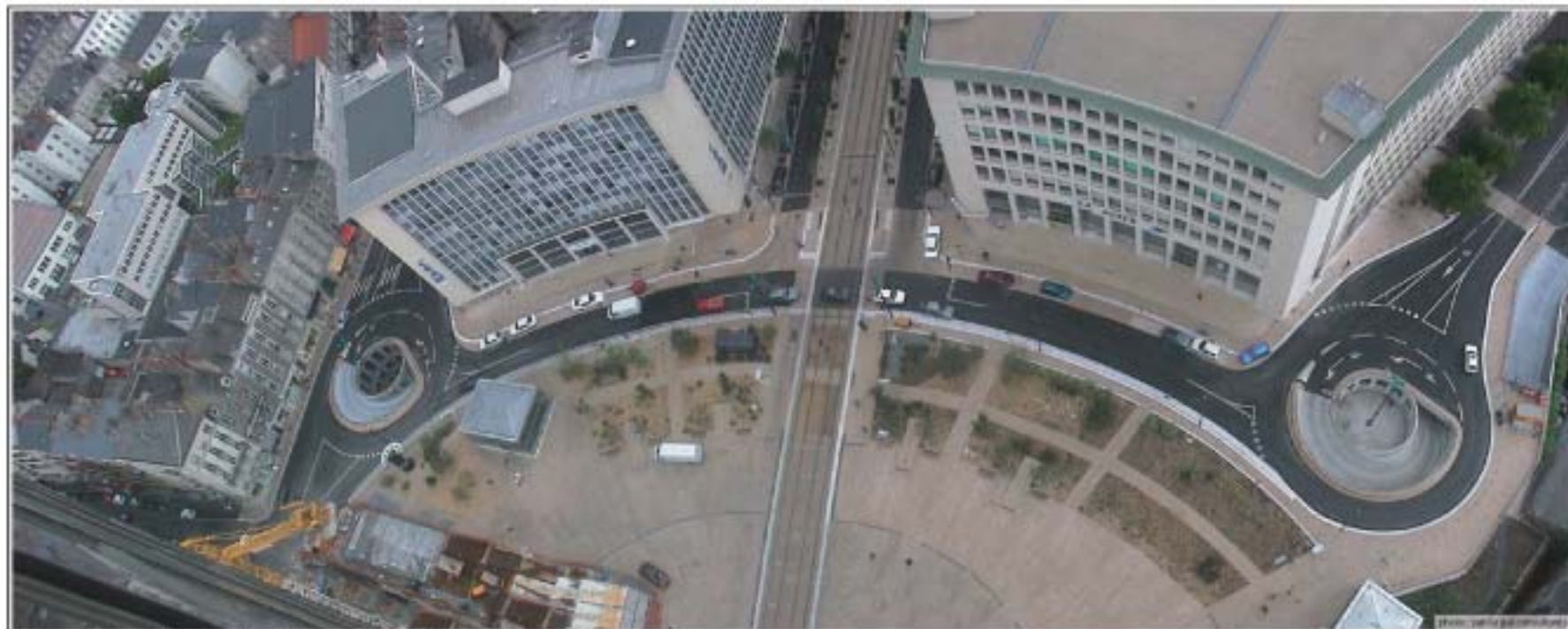
Les 2 nouvelles entrées au parking Bretagne ont été intégrées à 2 ronds-points
