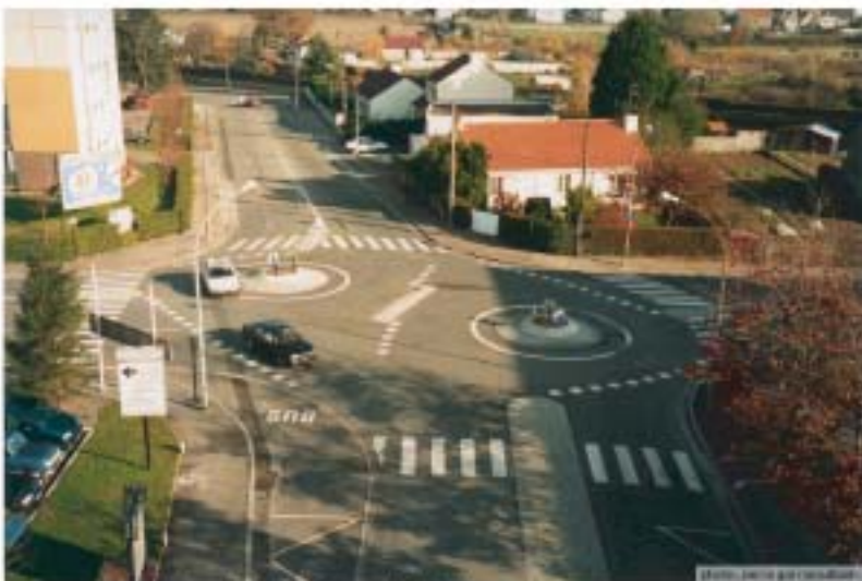
Le premier rond-point double de France à la Bottière
