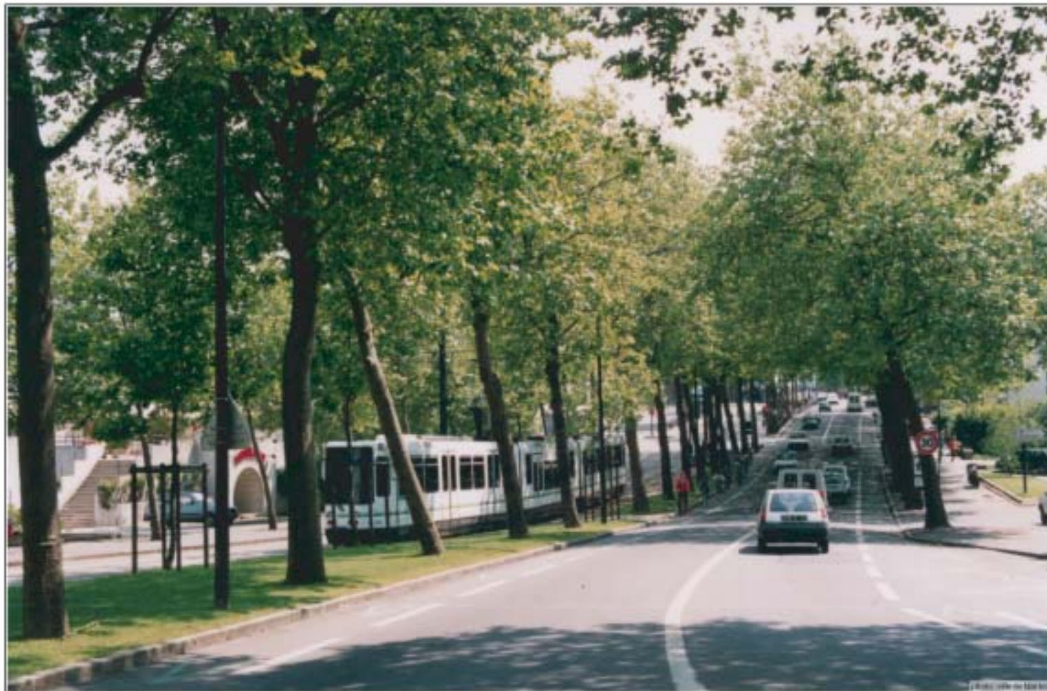
Avec la ligne 2 de tramway, le boulevard du Petit Port est passé de 2x3 voies à 2x1 voies
