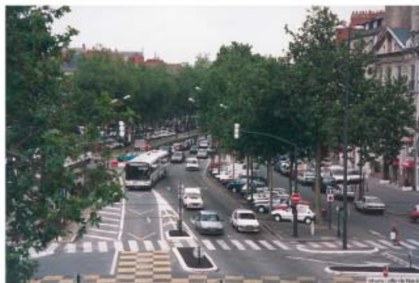
Avant transformation, ce Cours écoulait 15 000 véhicules par jour sur 2 voies
