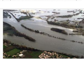
Crue de 2002 - Vue amont du pont de Pont-Saint-Esprit.
