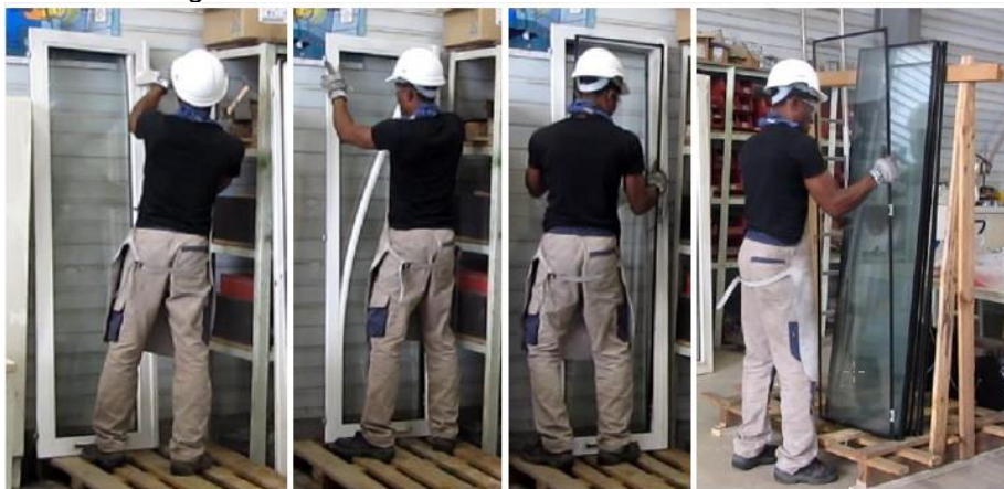
Figure 4 - Démantèlement de fenêtre
