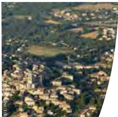
La pression de construction dans le PNR du Luberon est assez forte.
