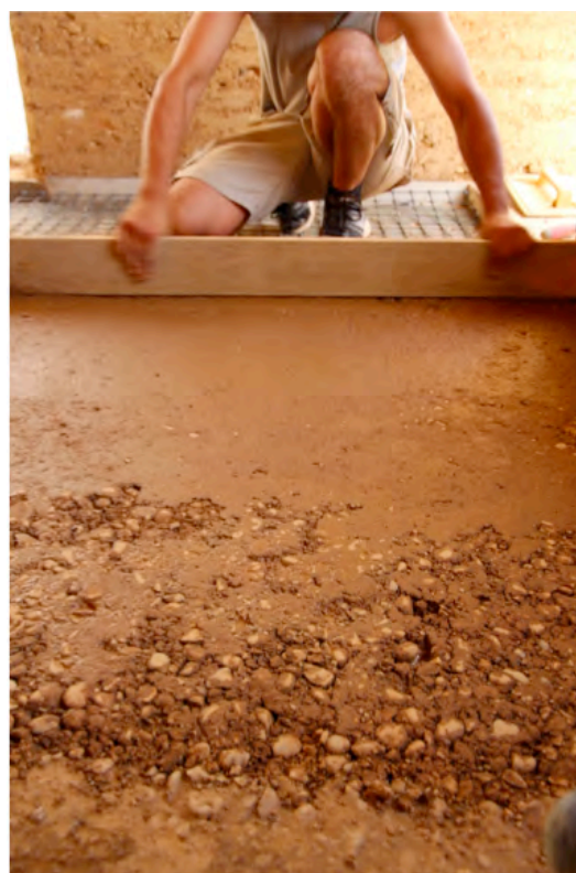
Mise au point et réalisation de sols en bétons d'argile coulés non stabilisés aux Grands Ateliers (2013)
