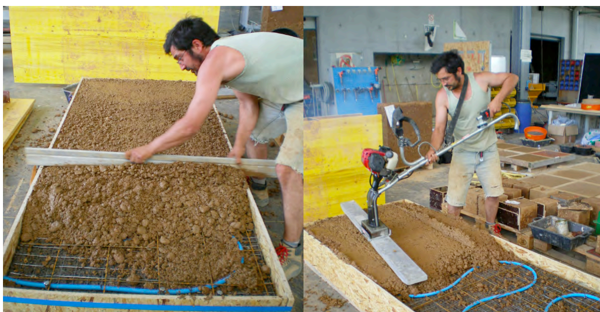
Réalisation d'une dalle en béton d'argile vibré avec chauffage au sol
