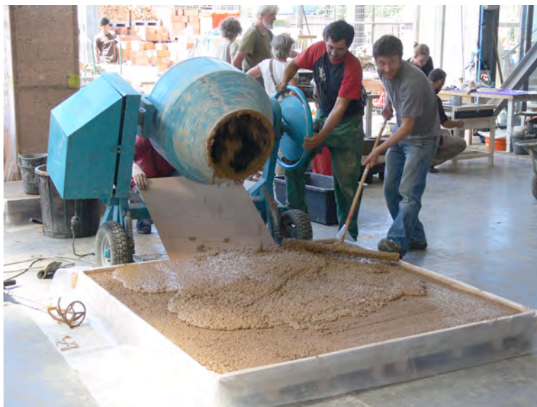
Dalle coulée en béton d'argile environnemental réalisé avec la terre à pisé de Brézins sans stabilisant (2012)
