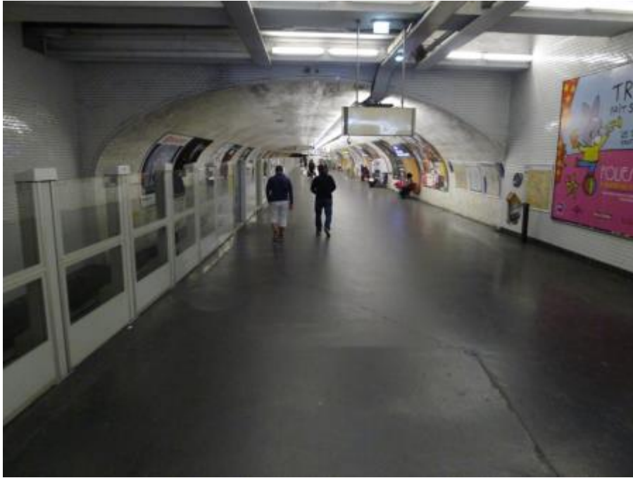
Photo 36: Quai de métro muni de portes palières
