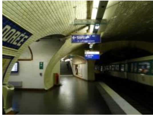
Photo 19: Signalétiques des sorties en queue de quai
