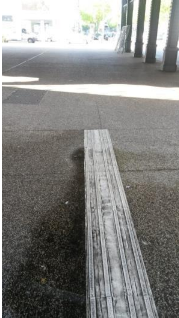
Photo 52 : Arrêt d'une bande de guidage sur trottoir élargi
