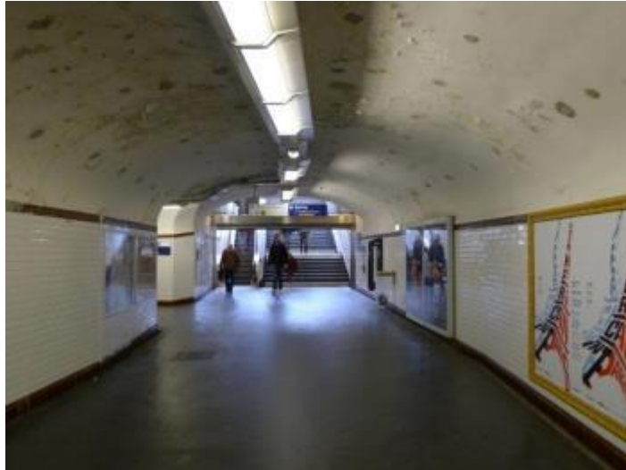
Photo 24: Eclairage d'un couloir de la station menant aux sorties 1 et 2
