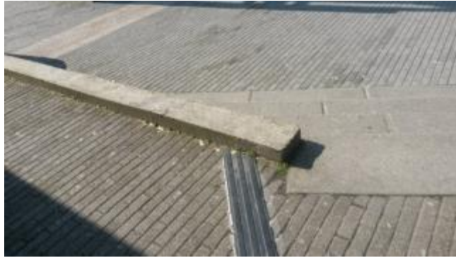
Photo 42 : Bande de guidage de la sortie de la gare SNCF pour atteindre la station de tramway, suivie d'un muret permettant de se repérer
