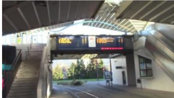
Photo 46 : Informations dynamique d'horaires des différentes lignes desservant la station grand place
