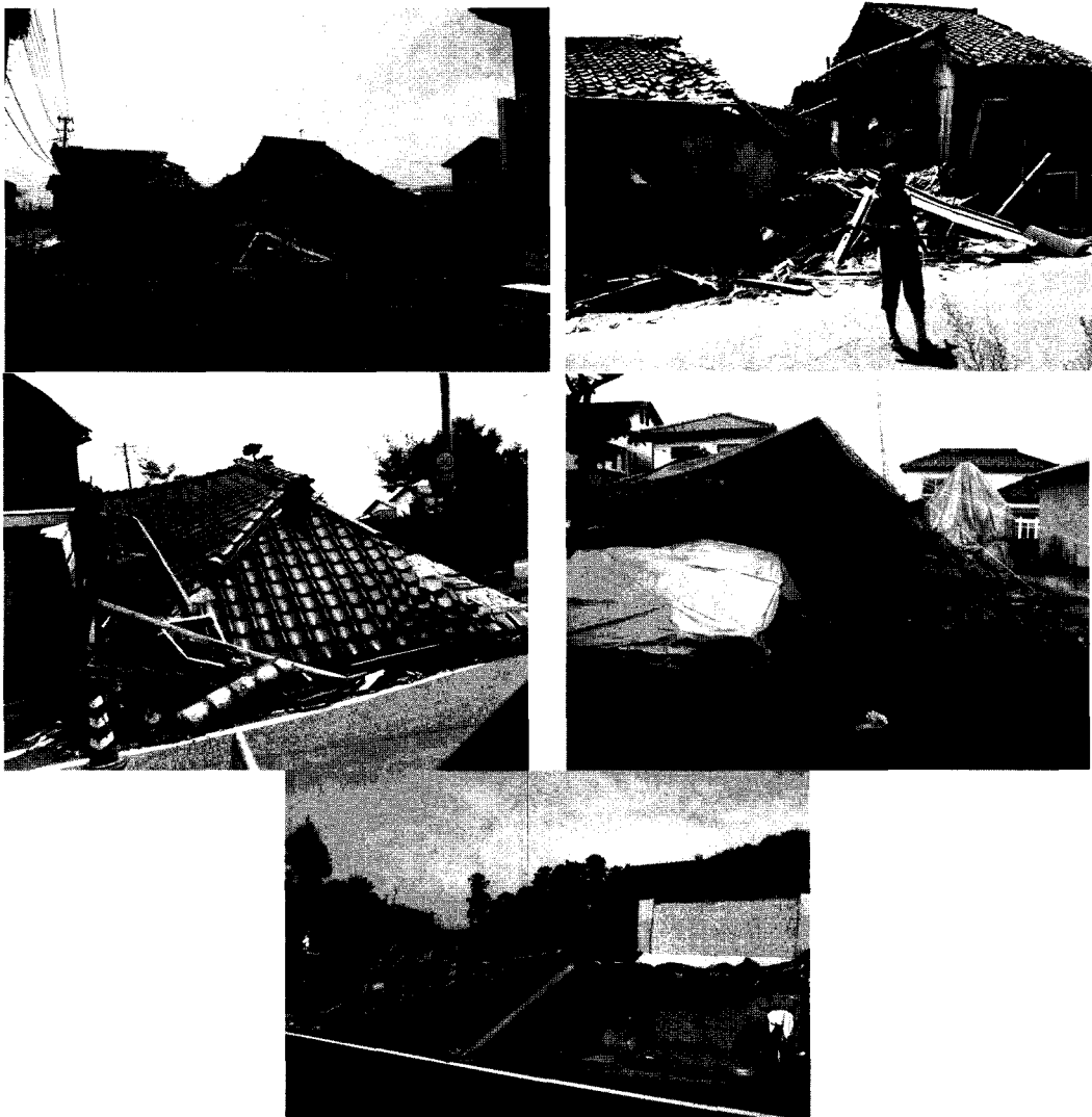
Figure 3.19 : Dommages liés au manque de contreventement et à la présence de toitures lourdes
