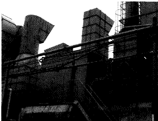
Figure 2.37: Réseau aérien corrodé, mais souple
