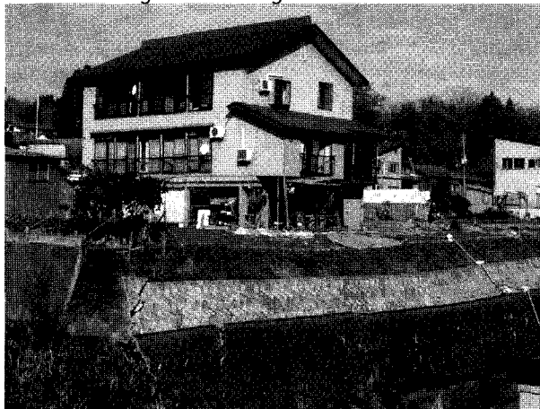
Figure 6 : Habitation de Wanazu ayant subi des dommages localisés (avancée du premier étage)
