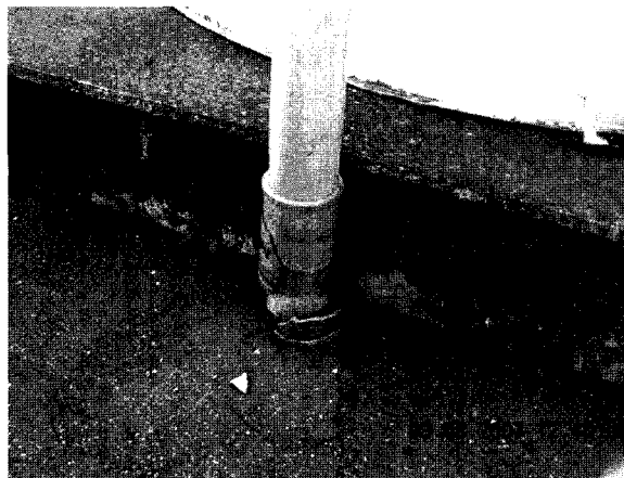
Figure 2.16 : Rupture de tuyauterie sur le réservoir (mouvement différentiel).
