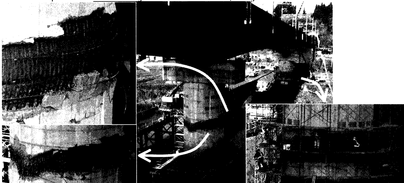
Figure 4 : Dommages subis par le pont du Shinkansen à Wanazu suite au séisme de 2004
