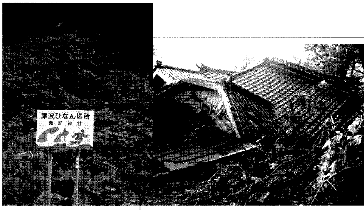
Pancarte indiquant un abri en hauteur pour se protéger d'un tsunami (photo de gauche), abri tsunami effondré, source AFPS
