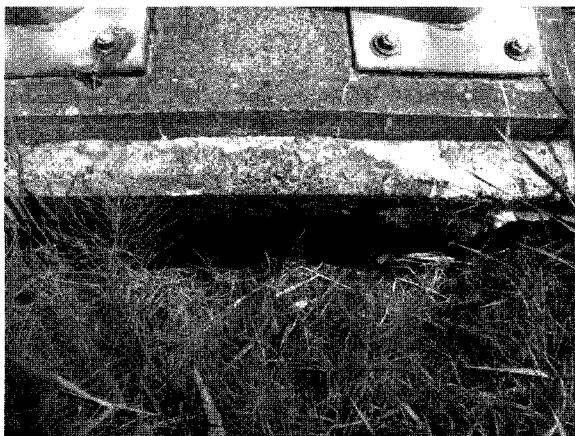
Figure 2.23: Mouvement et tassement de sol autour des fûts en béton et du réservoir métallique
