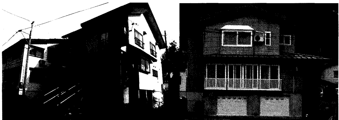
Figure 10 : Habitat à Wanazu – Reconstruction intégrant protection parasismique et identité locale
