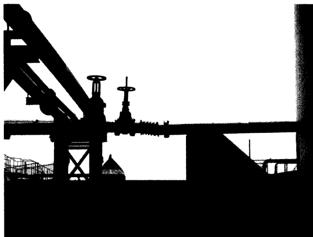
Figure 2.24 : Accommodation du réseau de tuyauteries aériennes, déformations au niveau des soufflets
