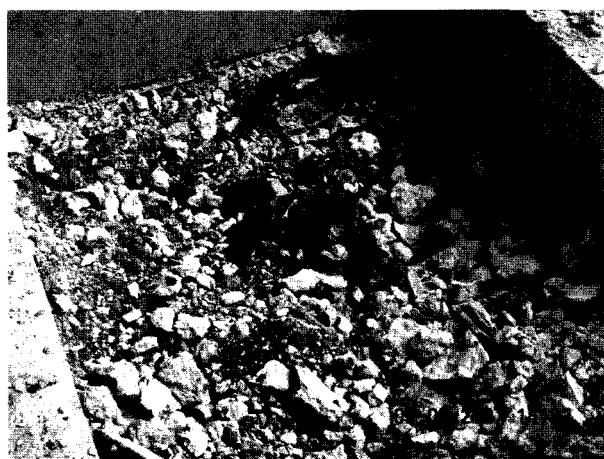
Figure 2.34 : Recherche d'une fuite du réseau enterré de distribution de carburant.
