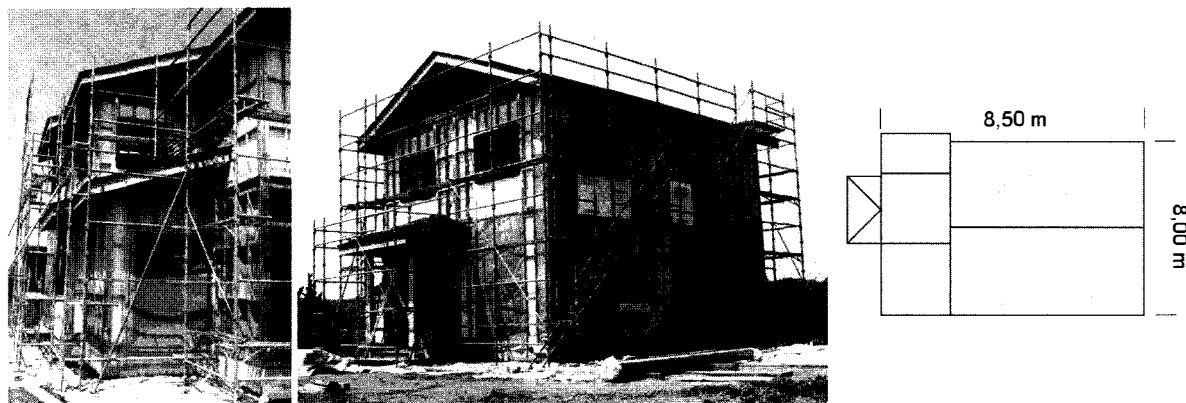
Figure 3.31 : Chantier 2, vue d'ensemble de la maison
