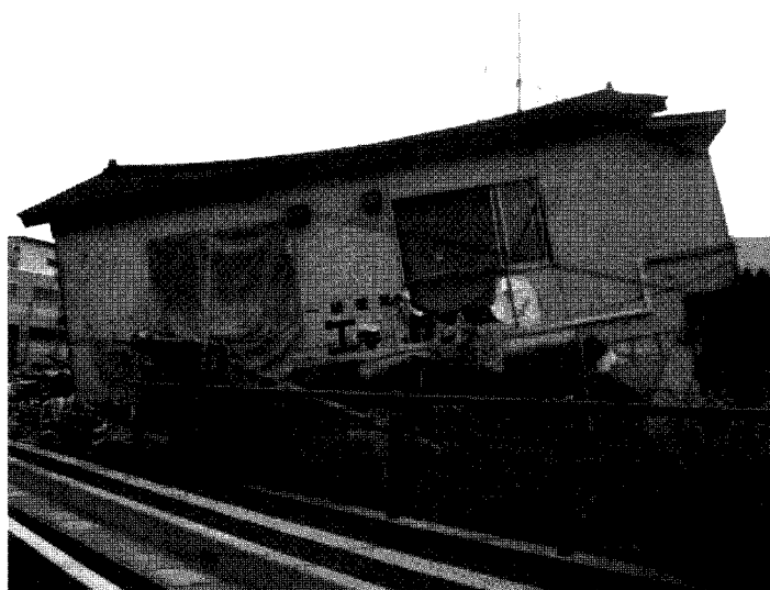
Endommagement à Kashiwazaki d'un cabinet d'architecte de 1 ère catégorie (agrée pour concevoir des constructions parasismiques), source AFPS
