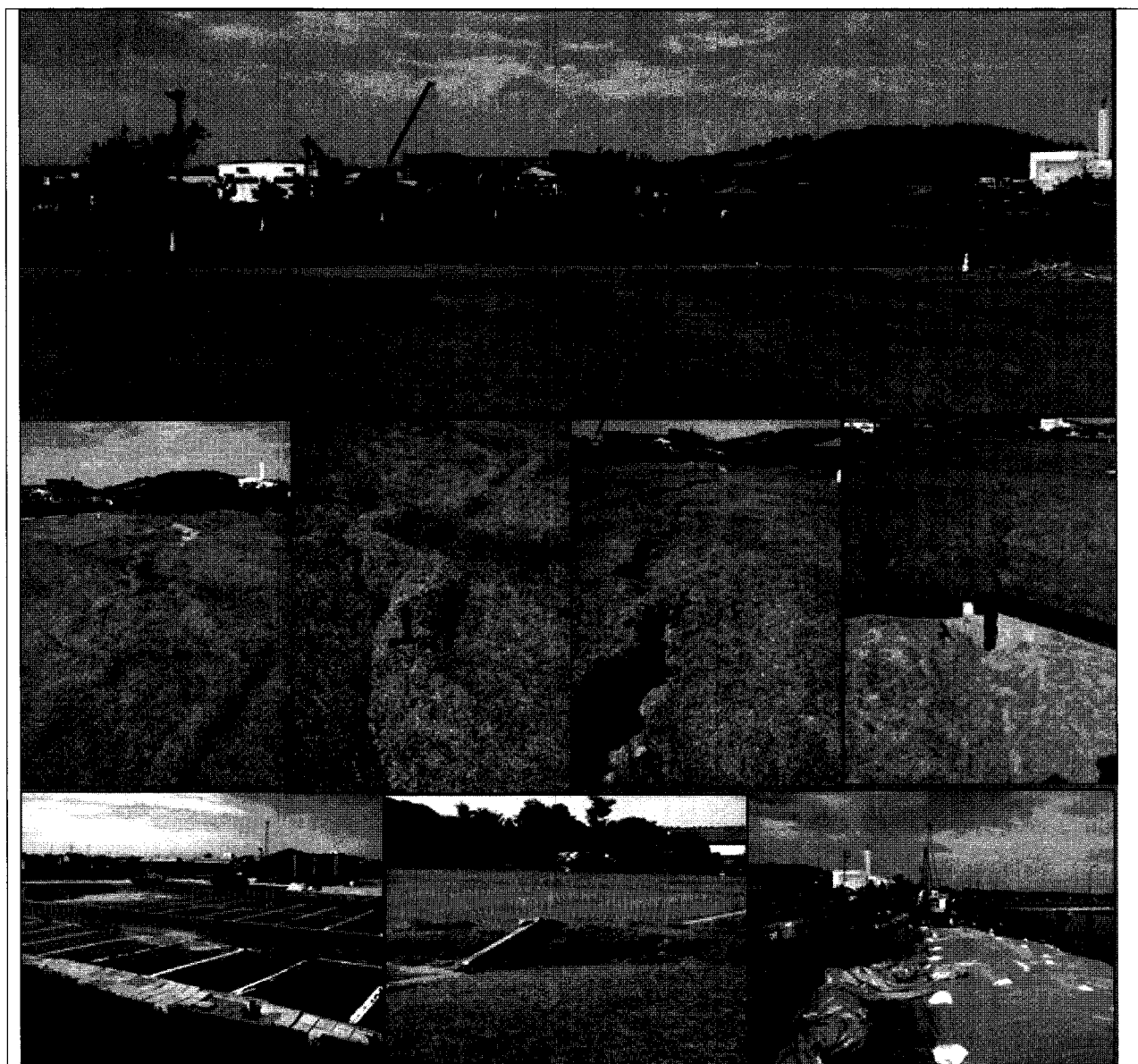
Figure 1-4-5: Glissement latéral, îlot Sabaishi (GPS : 37,390°N ; 138,576°E).
