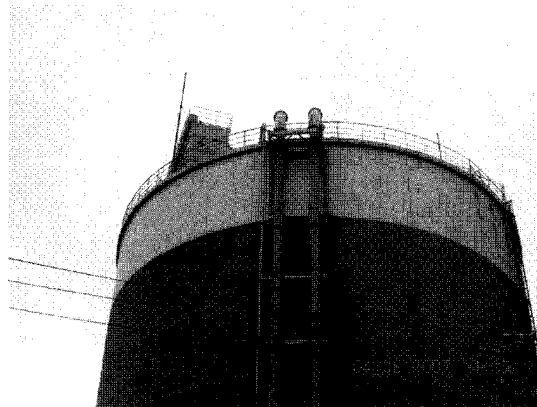
Figure 2.36: Le fût de la centrale à béton -et ses équipements-, ne comportent pas de trace d'endommagement.
