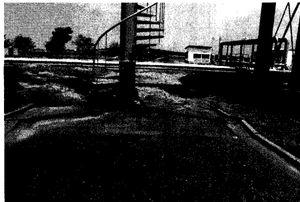
Figure 2.33 : Périphérie de la ville. Mouvement du pilier de la passerelle.
