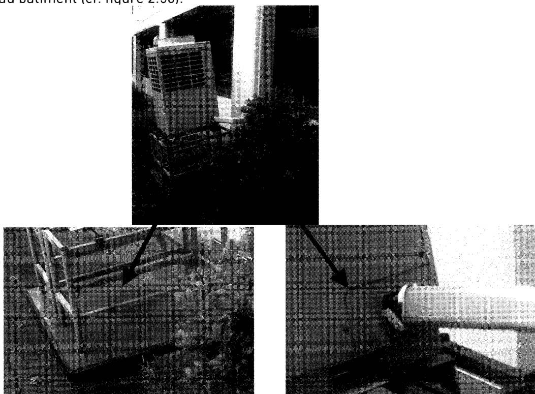
Figure 2.50 : Dommage observé sur les climatiseurs extérieurs en rez-de-chaussée [effet des mouvements différentiels]
