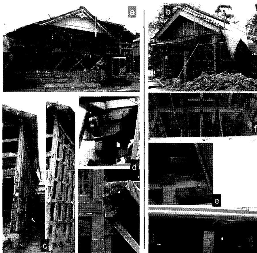
Figure 3.8 : Structure bois traditionnelles des temples et variante récente avec triangulation a) grand temple traditionnel de Kashiwazaki, c) détails des murs latéraux non contreventés, d) détails d'assemblages poteau-poutre traditionnels, b) Petit temple en construction, e) détail du plancher et de ses supports, f) détails de la charpente,
