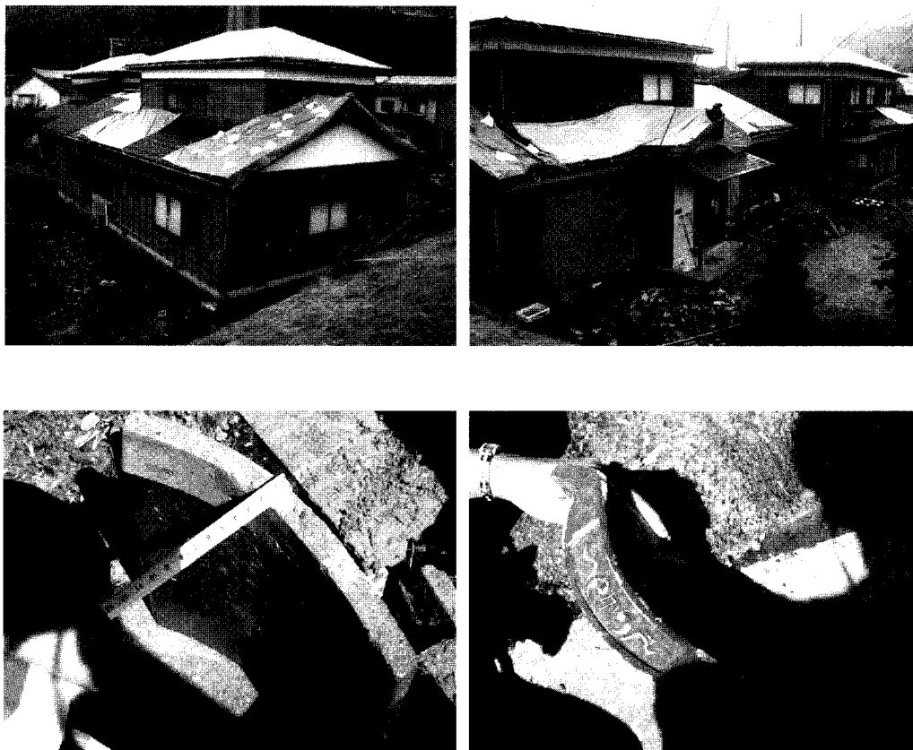
Figure 3.20 : Chutes de tuiles
