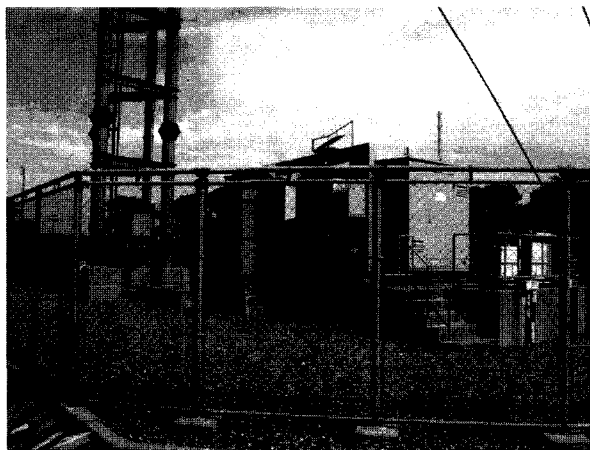
Figure 2.47 : Pylônes du relais de communication
