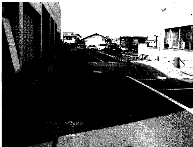
Domages aux réseaux enterrés reliant le bâtiment principal de l'hôpital (gauche de la photo) au bâtiment énergie (à droite de la photo), source AFPS
