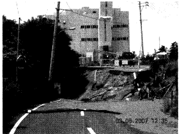
Figure 2.13 : Glissement de terrain à proximité de l'incinérateur illustrant les mouvements de sol.
