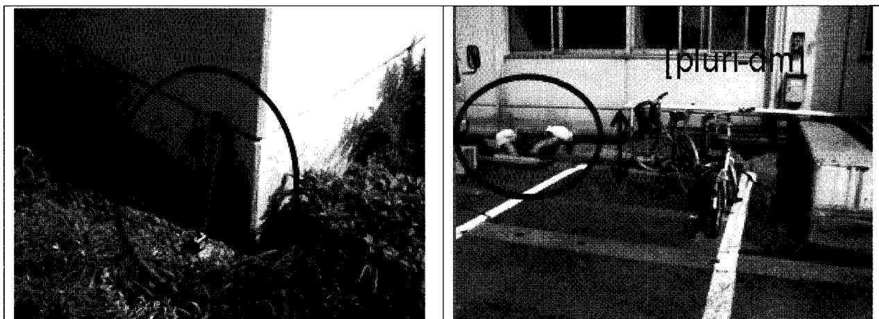
Figure 1-4-8: Liquéfaction à l'hôpital de Kashiwasaki (GPS : 37,362°N ; 138.578°E).
