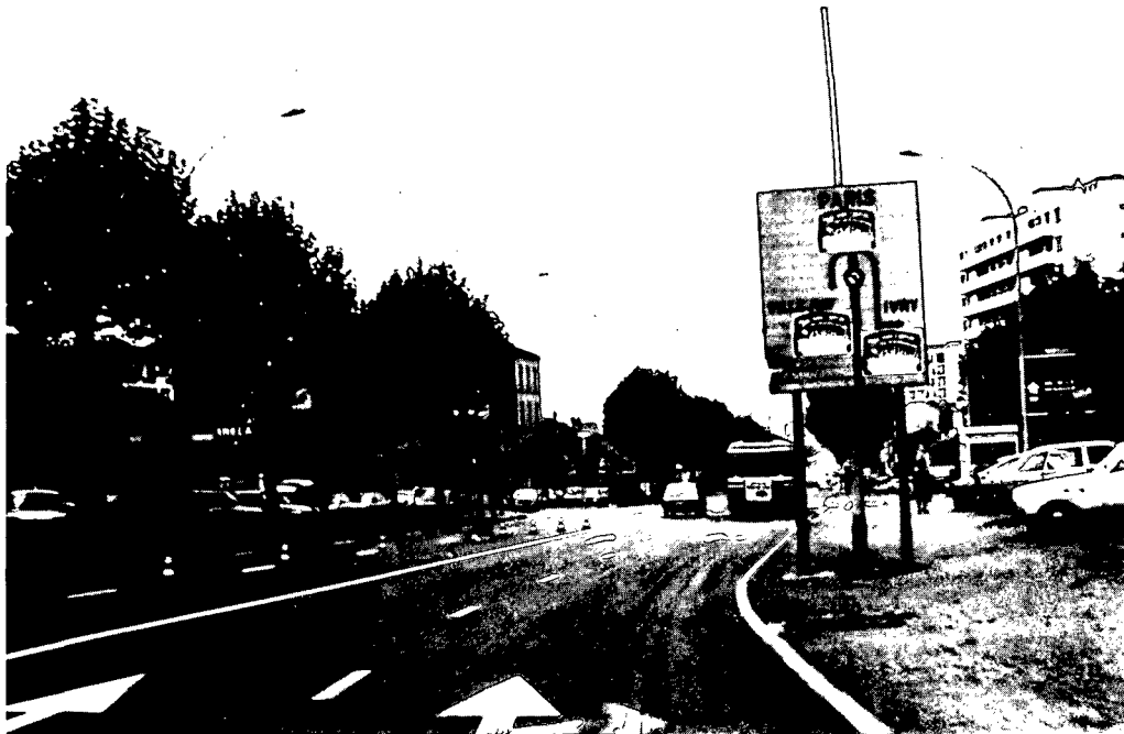
Le panneau directionnel masque le feu sur potence implanté en sortie de virage.
