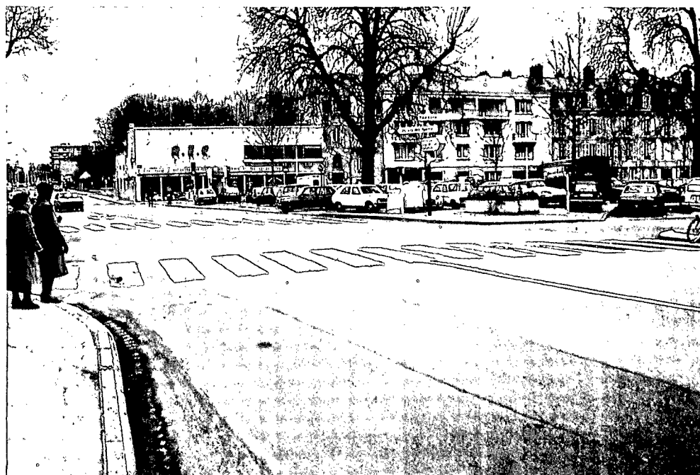
Photo 31 : Traversée des mails au niveau du complexe scolaire rue E. Vignat
