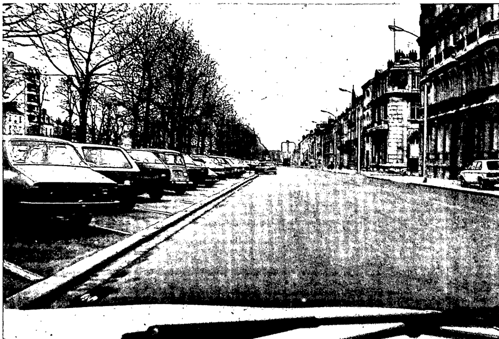
Photo 26 : Stationnement en épis à gauche sur les mails
