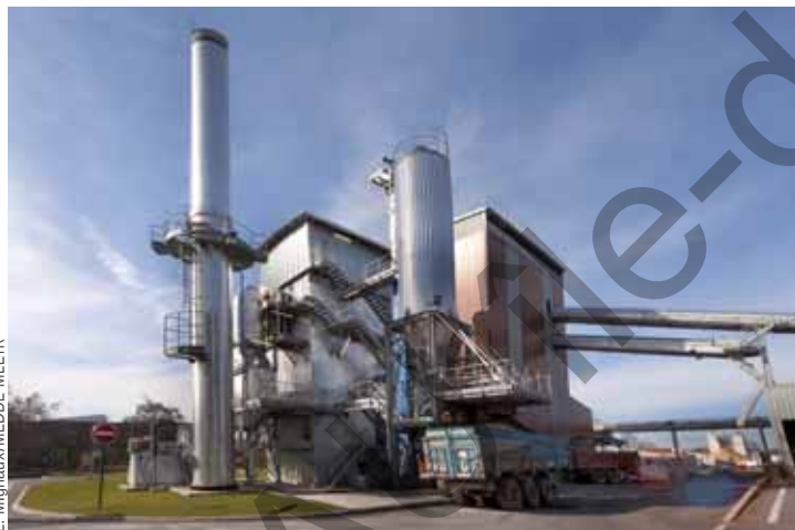
Chaufferie biomasse à Cergy (95)
