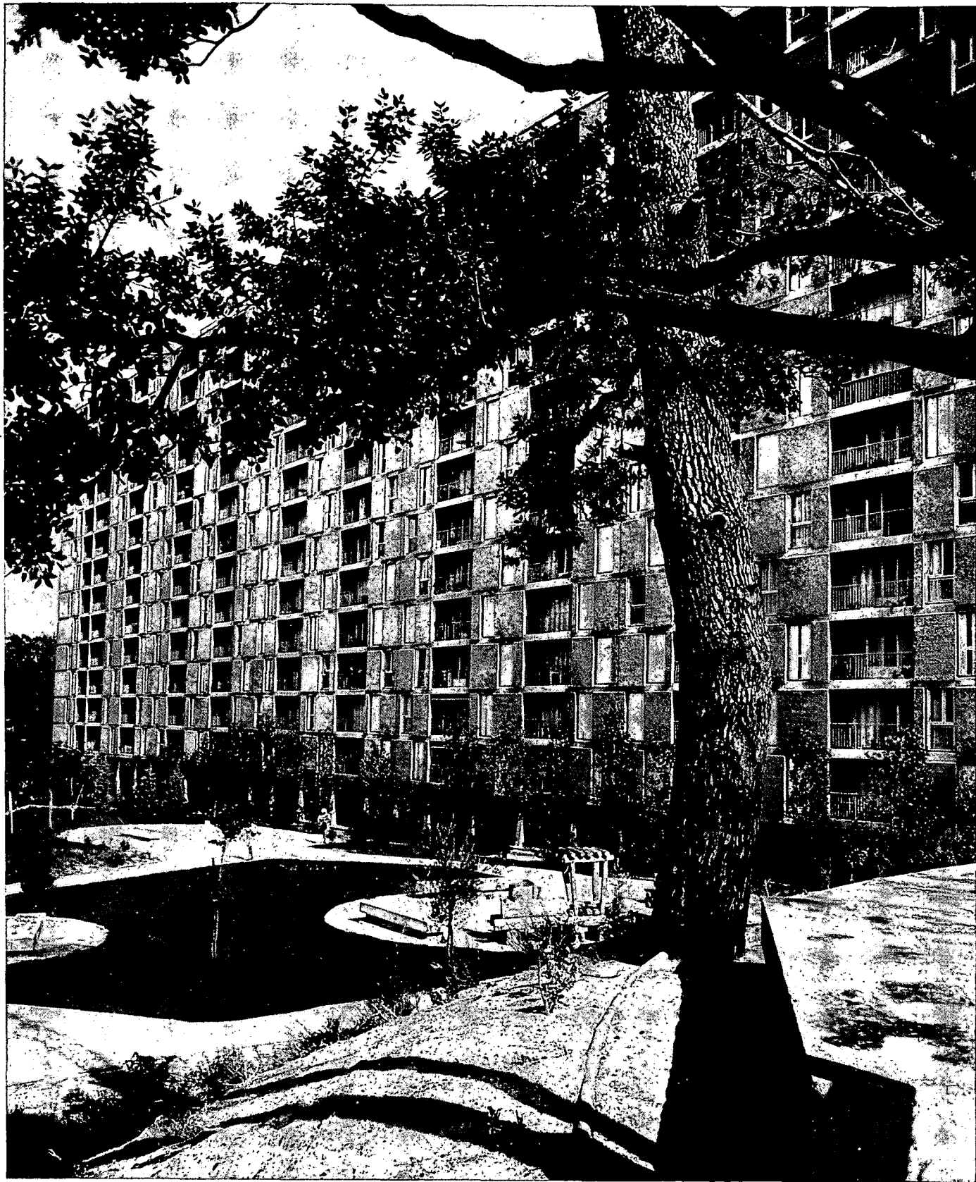
Marseille (Bouches-du-Rhône), « H.L.M. les Oliviers », 1971.
