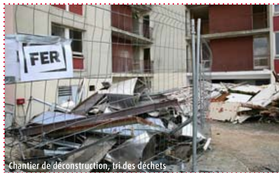
Chantier de déconstruction, tri des déchets
