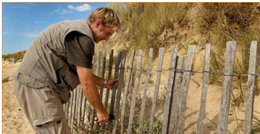
Réparation d'une clôture protégeant le cordon dunaire à Erdeven, dans le Morbihan (56).
