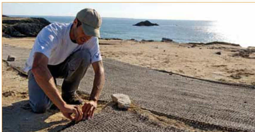
Pose de géotextiles pour limiter l'érosion à Quiberon, dans le Morbihan (56).
