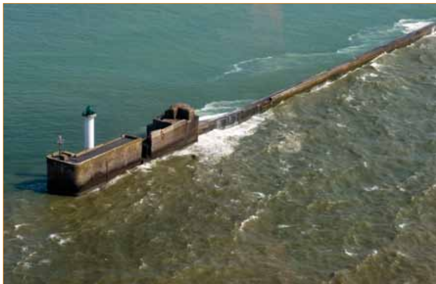
Digue à Boulogne-sur-Mer, dans le Pas-de-Calais (62).
