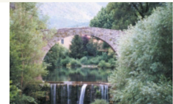
Pont au Vigan (Gard) Photo : Mate
