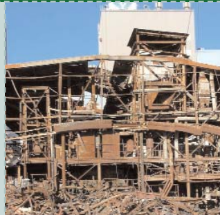
Chantier démolition SBM Diren©
