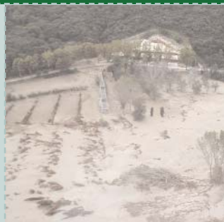
Pont du Gard, rive droite 2004-Diren©
