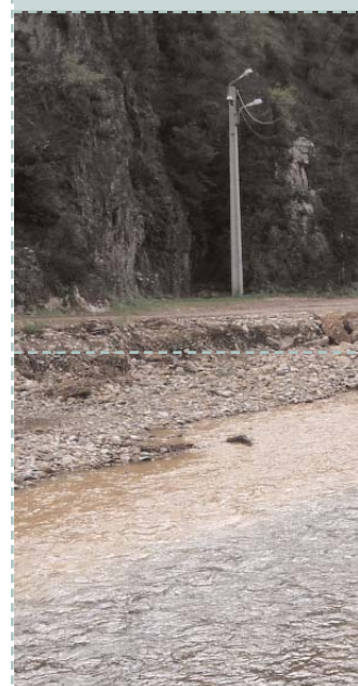
Travaux avène - Diren LR©
