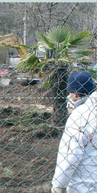
SLM pendant travaux dépollution Diren.LR©
