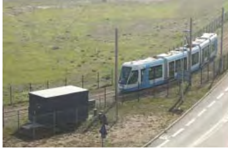
Figure 2: sous-station réversible à La Rochelle
