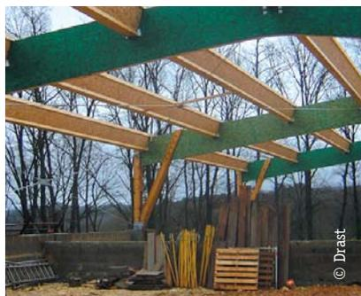
Pour cette poutre creuse à section triangulaire, composée de trois membrures en bois massif reliées par trois âmes en panneaux OSB, l'ouvrage de référence est un bâtiment de la communauté de communes du Monpaziérois, en Dordogne.
