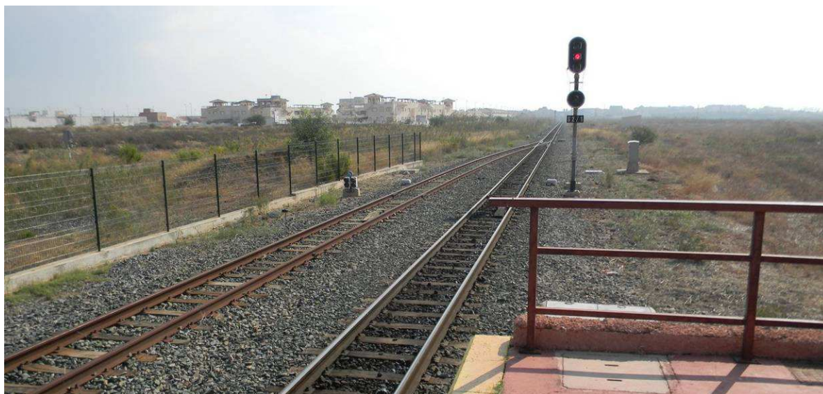
Exemple d'évitement avec signal de block sur la ligne FEVE de Carthagène à Los Nietos (Province de Murcie).
