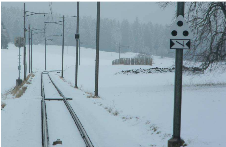
Figure 99 Franchissement du PN
