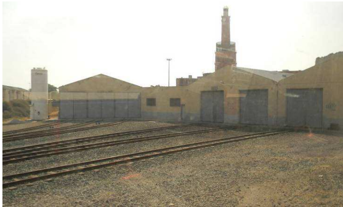
Figure 125 Vue extérieure du dépôt-atelier à Carthagène
