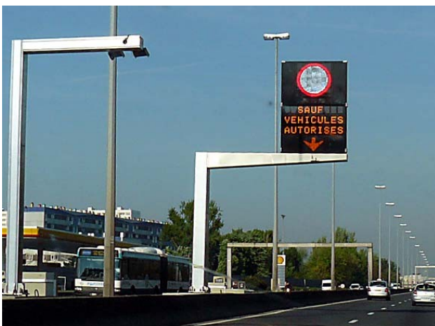
Réservation d'une voie de circulation
