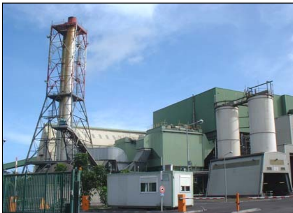
La Centrale thermique du Moule fonctionne avec de la bagasse pendant la campagne sucrière
