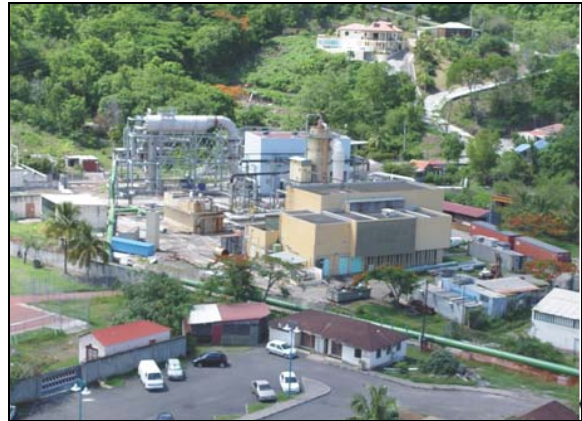
Centrale géothermique de Bouillante
