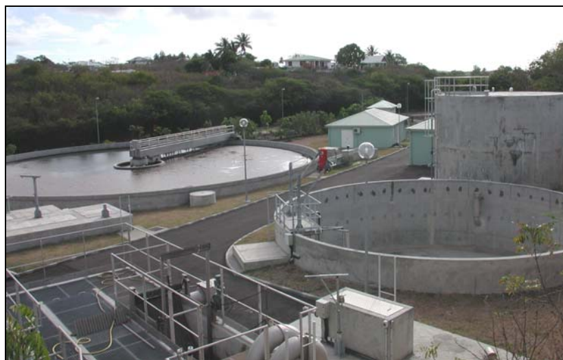
Station d'épuration de Saint-François
