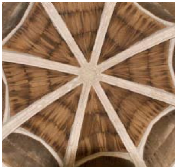
Charpente du donjon du château de Vincennes (Val-de-Marne) dont la construction a été ordonnée par Charles VI. Les pièces de châtaignier visibles au centre de l'ouvrage proviennent de Riga (Lettonie). La France peine toujours à valoriser les essences nobles des feuillus pourtant abondants sur son territoire.
