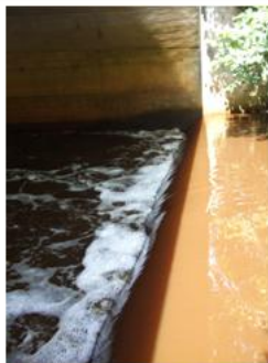
Seuil du pont Bumet (palplanches)
