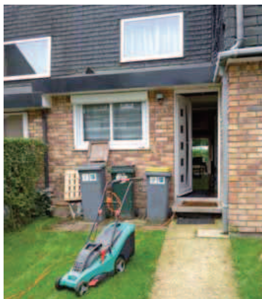
Jardin de devant et intérieur traversant d'une maison mitoyenne d'un lotissement à Cesson.
