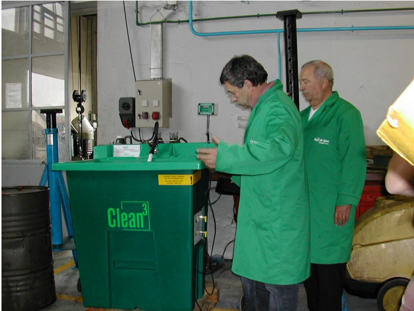
Installation d'une fontaine biologique sur le site de Besançon
