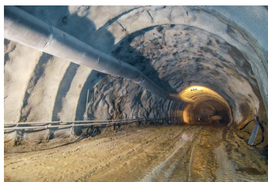
Tunnel de Boccognano
