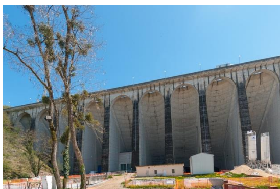
Barrage de la Pannecière
